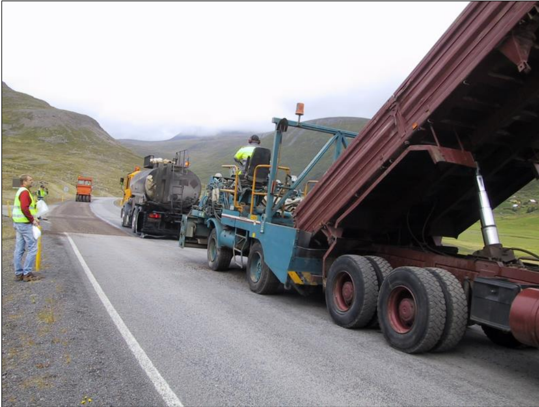
Mynd 1.2 Útlögn tilraunakafla með klæðingu í Tungudal 2003
